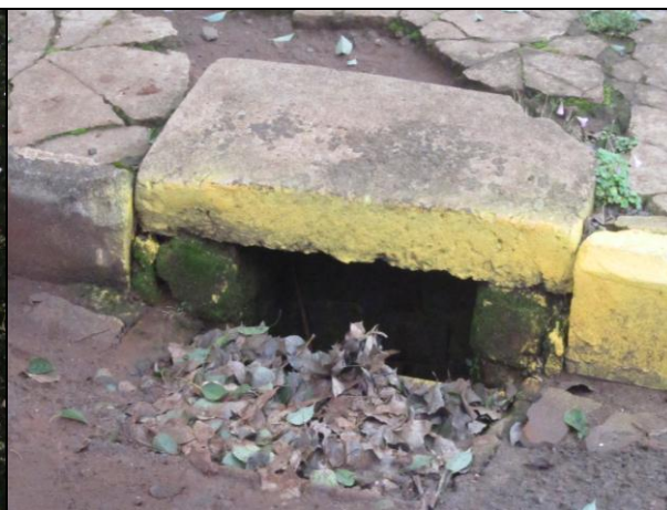
FOTO 04 – Boca de Lobo
