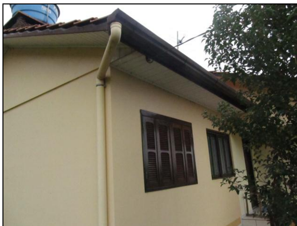
FOTO 03 – Infraestrutura de Drenagem
